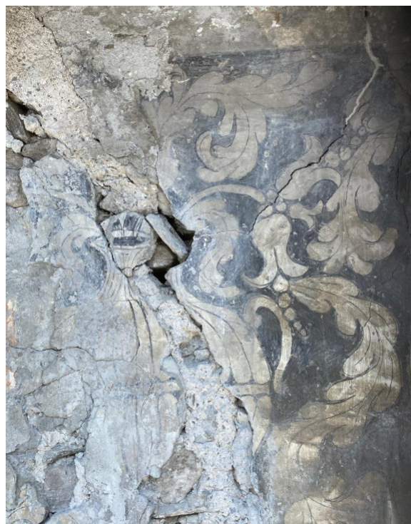
Un particolare della parete di Casa Ronsil prima del restauro del 2022.
