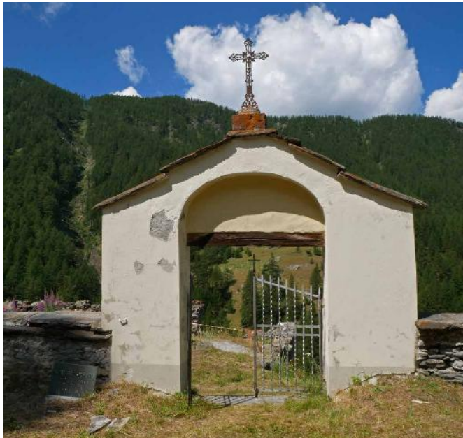
La nuova croce donata da don Pasqualino posizionata sull'ingresso del cimitero di Laval
