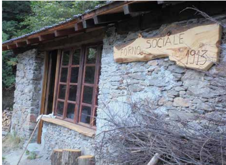
Vista del forno ristrutturato (Luglio/Agosto 2015)
