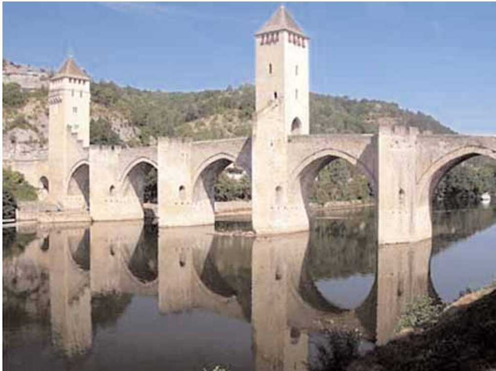
- Lou pont de Ventré à Caours -
